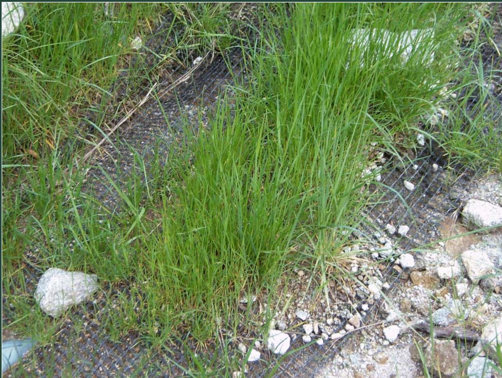
*Oropa (BI) – Particolare delle canalette di scolo autoadattanti inerbite e fissate dai PRATI ARMATI®*
